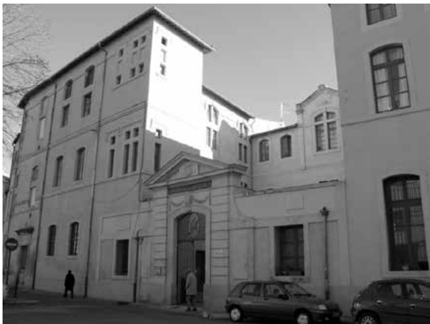
Fig. 6. L'hôpital Ruffi (aujourd'hui foyer Albaric) avec les travaux d'agrandissement successifs des XVII e , XVIII e et XIX e siècles.
