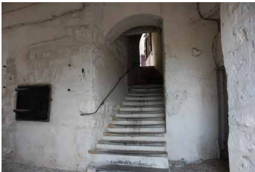
Fig. 2. « Sauve minérale », escalier, cliché de l'auteur.
