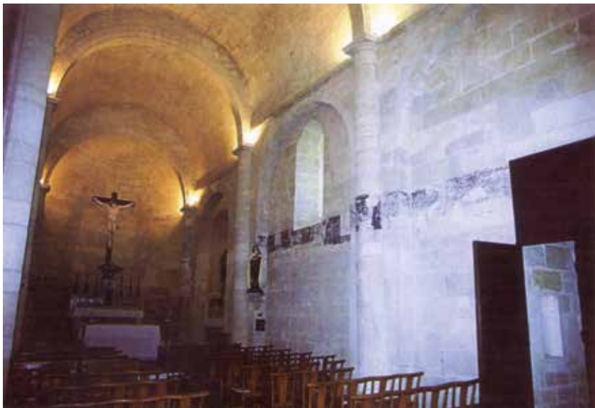
Fig. 5. Intérieur de l'église. On y distingue les restes d'une litre. Après bien des vicissitudes dues aux guerres de Religion et de nombreux travaux de restauration au cours des siècles, l'église présente actuellement son aspect primitif obtenu de 2000 à 2005 suite à l'ultime restauration confiée aux architectes Laurent Dufoix et Antoine Bruguerolle. (Cliché Bernard Atger).
