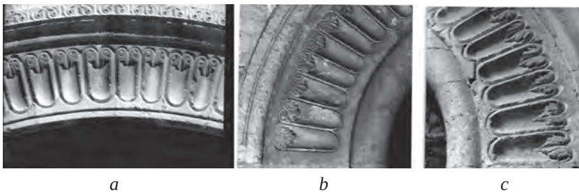
Fig. 21. Cannelures rayonnantes à ménisque orné d'une palmette à l'église du Thor (a), au cloître de Saint-Paul-de-Mausole à Saint-Rémy (b), et à l'abbaye Saint-André de Villeneuve-lès-Avignon (c).
