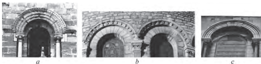
Fig. 4. Baie principale de la façade sud, à l'église du Thor (a), baies au chevet de la priorale de Paray-le-Monial (b) et à l'église de Saint-André-le-Bas, à Vienne (c).
