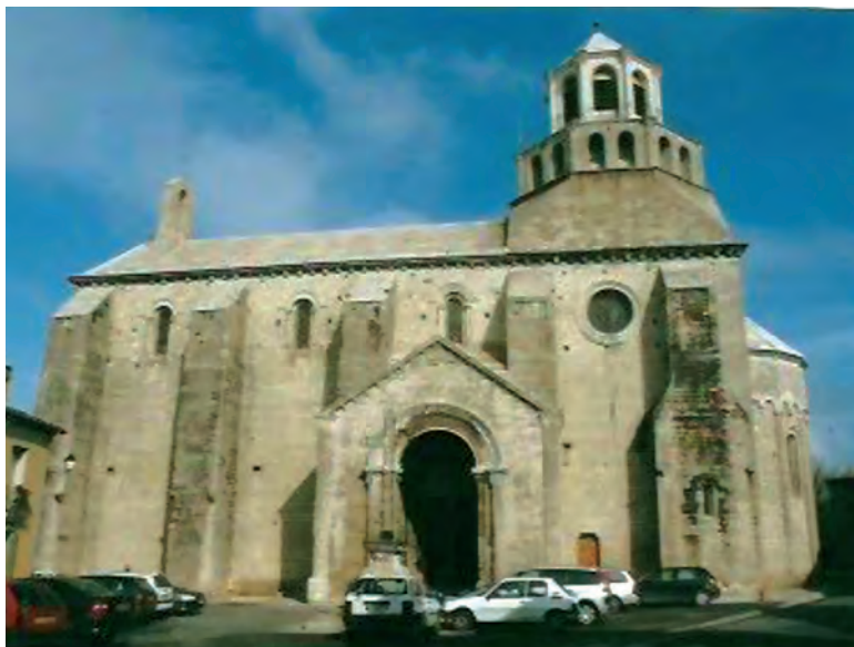
Fig. 1. Le Thor, église, façade sud.
