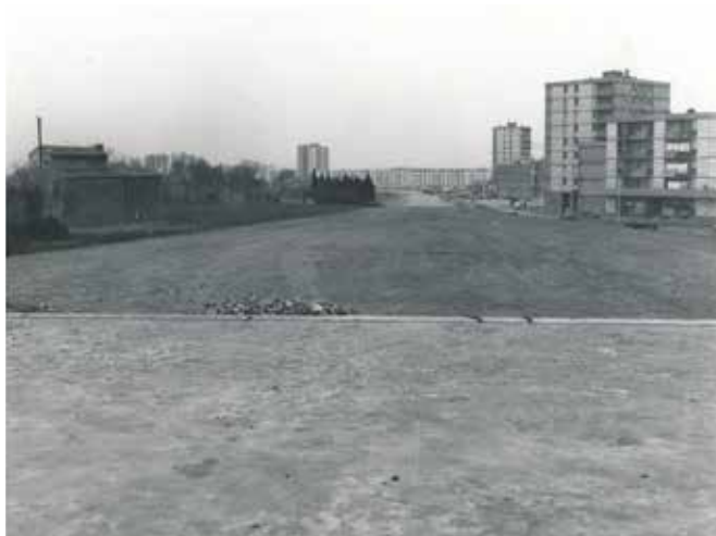
Fig. 1. Début des constructions du quartier sur des terres agricoles début années 1960 (© Fonds Hervé Collignon).
