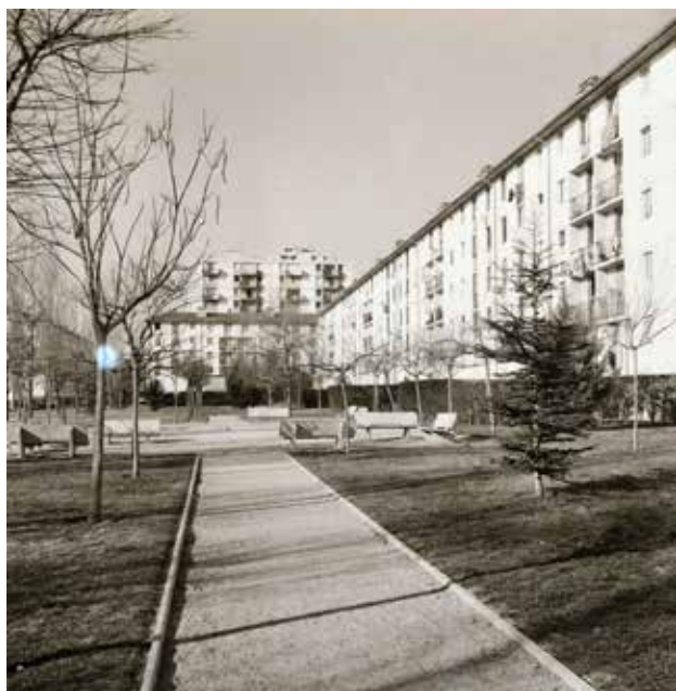
Fig. 2. Immeubles côté avenue Delattre de Tassigny quelques années plus tard (© Fonds Hervé Collignon).
