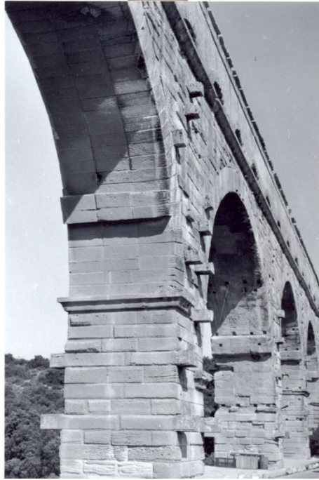
Fig. 1. Le Pont du Gard. Pile avec bossage irrégulier et boutisses. Voûte faite d'arcs juxtaposés avec claveaux-console. Photo V. Lassalle/ musée archéologique de Nîmes.
