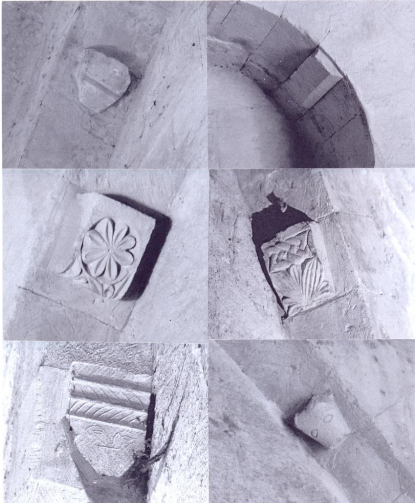
Fig. 4. Tresques (Gard) . Chapelle romane Saint-Martin-de Jussan. Claveaux-consoles différant par leur forme et par leur décor.
