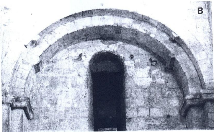
Fig. 3. Abbatale Notre-Dame de Montmajour. Arcade murale d'une travée. La photographie (B) montre les claveaux-consoles. Le dessin d'Henry Révoil (A) ne les représente pas.
